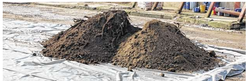
Der ausgelaufene Dieseldieselkraftstoff hat neben asphaltierten Flächen auch größere Mengen Erdreich kontaminiert, das abgegraben wurde.
